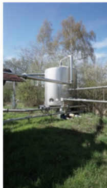
Hier wird die Kohlenstoffkonzentration und vom Wasser abgeschieden. Danach über gelangt sie über Rohrleitungen in die Reinigung und Verdichtung.
